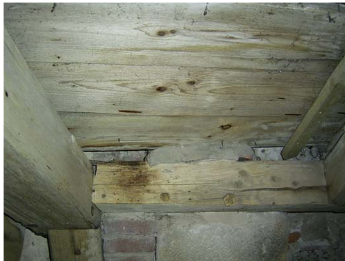
Abb. 4-21: Durchschlupföffnung zwischen Tür und Mauer (links) und am Dachansatz (außen erscheinen die Tiere unter der Dachrinne). Dort wo die Mausohren landen, ist das Gemäuer oder das Gebälk braun verfärbt. Fotos: A. Zahn
