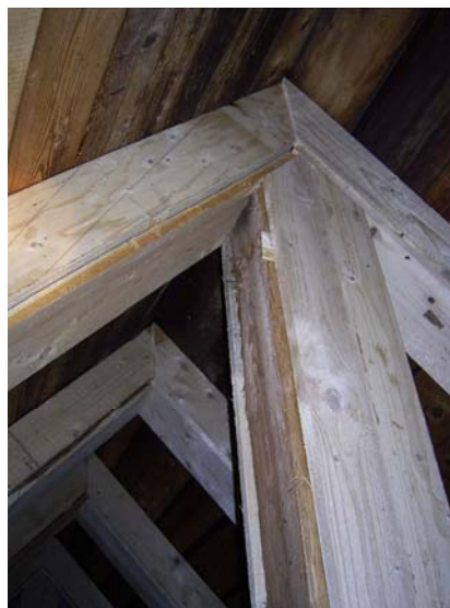
Abb. 4-27: Tragende Balken an den Hangplätzen wurden in Au (Bayern, D) zum Schutz von Kot und Urin mit Verschleißbrettern ummantelt. Die Tiere hingen schon im ersten Jahr an den neuen Hölzern, auch wenn Hangplätze an den alten Dachlatten bevorzugt wurden.
