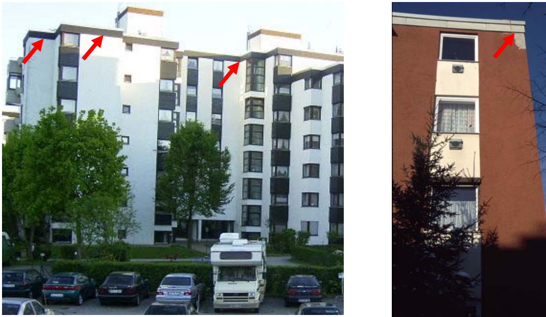
Abb. 4-28: Abendseglerquartiere hinter Holzverkleidung (Wasserburg, Bayern, D, links) und Eternitverkleidung (Waldkraiburg, Bayern, D, rechts) an Flachdachkanten. Fotos: A. Zahn
