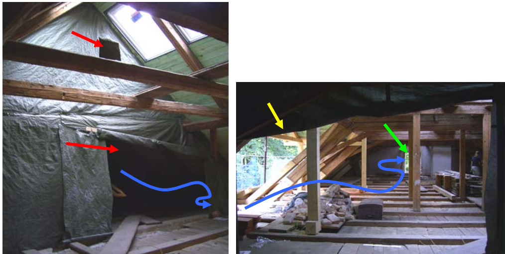
Abb. 4-6: Sanierung Kraftwerks- und Wohngebäude Aschau (Bayern, D). Provisorisch mit Folie abgetrennter Fledermausbereich (linkes Bild) mit ständiger Durchflugsöffnung (roter Pfeil oben) und nachts geöffnetem Bereich (roter Pfeil unten). Zukünftiger Wohnbereich (rechtes Bild), vom Fledermausbereich aus gesehen, mit zukünftiger Dachterrassenöffnung (gelber Pfeil) und ursprünglicher Aus- und Einflugsöffnung (grüner Pfeil). Der Flugweg der Tiere bis zur Öffnung ist durch blaue Pfeile angedeutet. Fotos: A. Zahn.
