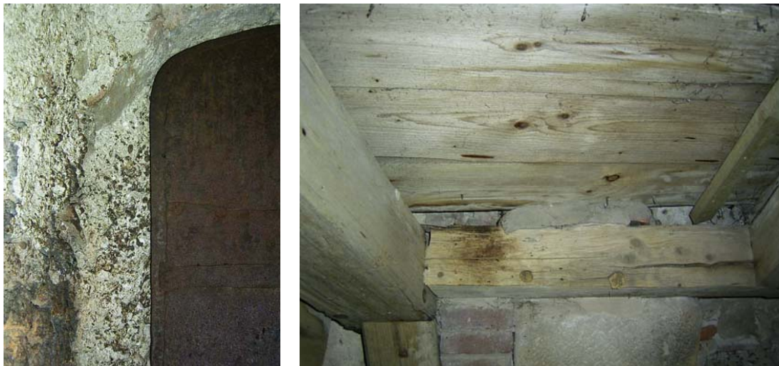
Abb. 4-21: Durchschlupföffnung zwischen Tür und Mauer (links) und am Dachansatz (außen erscheinen die Tiere unter der Dachrinne). Dort wo die Mausohren landen, ist das Gemäuer oder das Gebälk braun verfärbt. Fotos: A. Zahn
