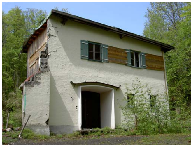
Abb. 4-12: Werkskantine Murnauer Moos (Bayern, D). Zwischen den Fenstern wurden Fledermausbretter montiert, die bislang nur von Einzeltieren angenommen wurden. Die Kolonie siedelt nach wie vor im Windbrett. Foto: B. Wimmer
