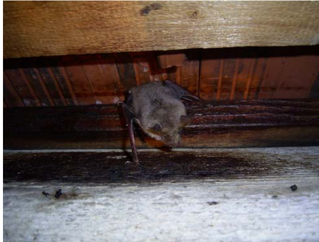
Abb. 4-20: Braune Verfärbung an Holz, Ziegel und Mauer eines Mausohrmännchenhangplatzes. Foto: A. ZAHN
