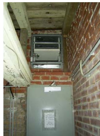
Abb. 4-4: Von Kleinen Hufeisennasen genutzte Ein- bzw. Ausflugsöffnungen sind immer durchfliegbar, können jedoch auch relativ kleine Durchmesser besitzen (Kirche Unteramlach, Kärnten, A). Das rechte Bild zeigt eine Feuerschutzklappe, die als Durchflugsöffnung für Kleine Hufeisennasen eingebaut wurde (Schloss Herrenchiemsee, Bayern, D). Fotos: K. Frühstück, A. Zahn
