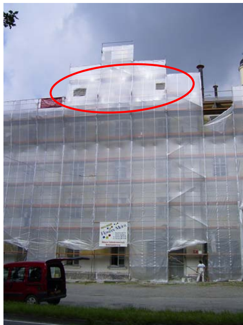
Abb. 4-17: Brauerei in Maxlrain (Bayern, D). Die Ausflugsöffnungen der rund 250-köpfigen Wimperfledermauskolonie befinden sich im obersten Dachgeschoß. 2005 wurde die Fassade saniert. Die Verkleidung wurde vor den Ausflugsöffnungen entfernt. Foto: A. Zahn
