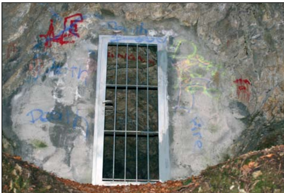
Repariertes Eingangstor. FOTO: KLAUS KRAINER
